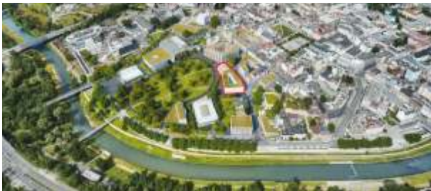
Pozemek Spilka Spilka site
